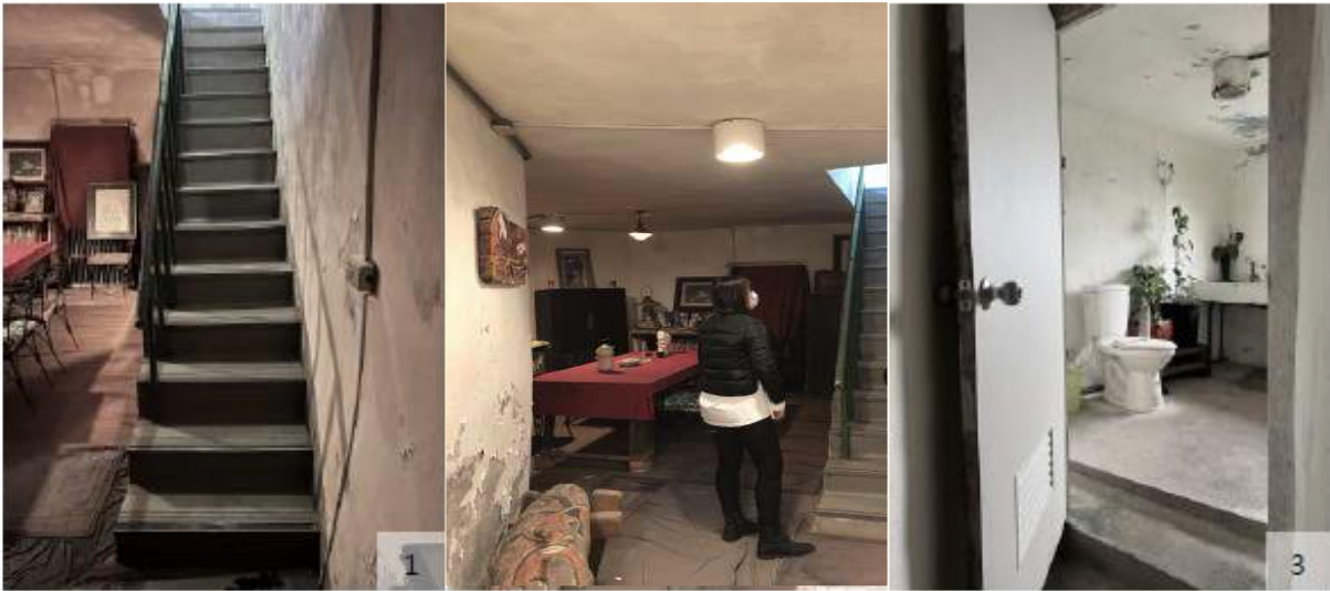
現況照片（1-3：往夾層樓梯/前段坑道/廁所）
