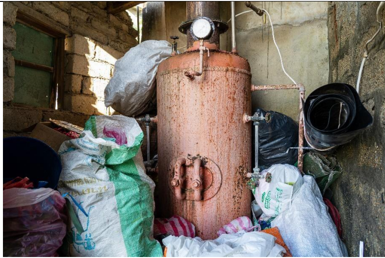
昔日製作醬油之鍋爐
