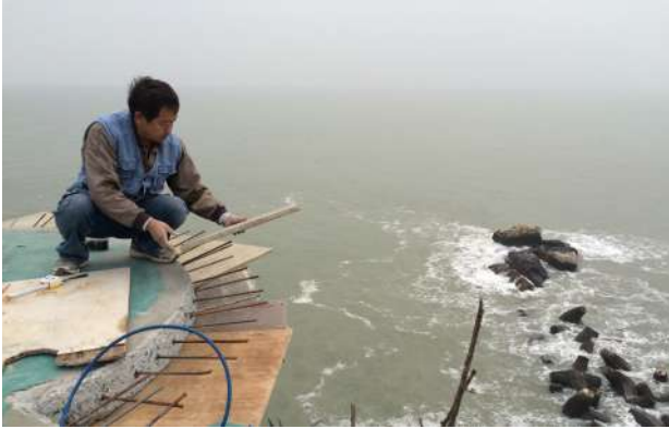
觀測所窗戶屋簷漏水補強
