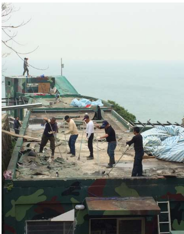
屋頂舊防水層拆除
