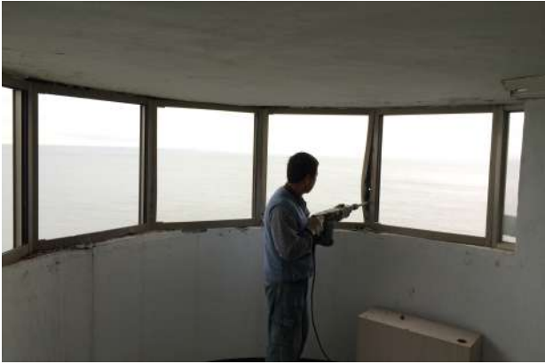
觀測所窗戶屋簷漏水補強
