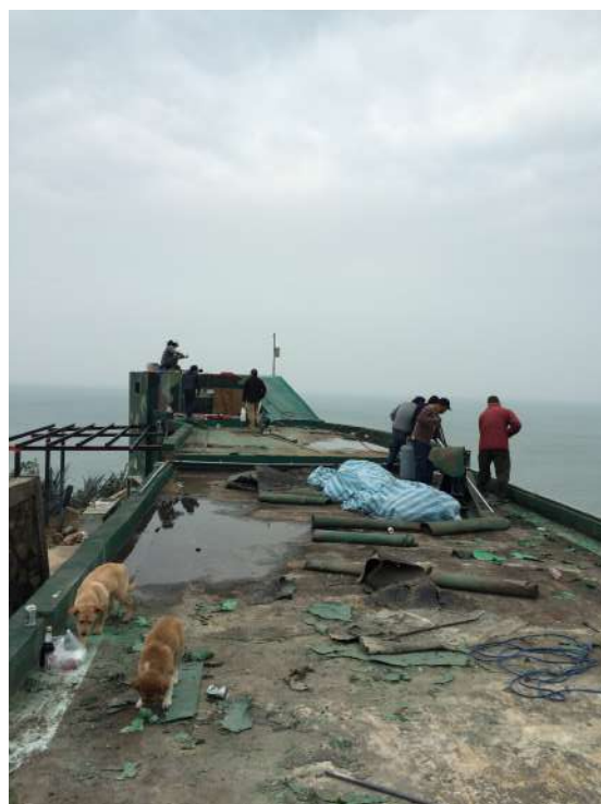
屋頂舊防水層拆除
