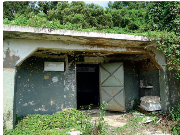
東引特約茶室入口現況
