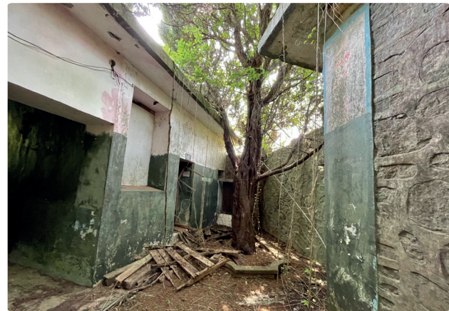
內部空間現況
